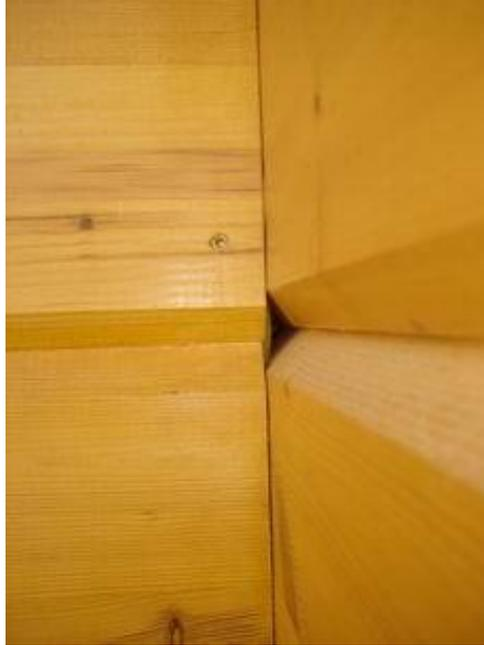
Im Geräteraum wird durch von außen einfallendes Licht ein Hohlraum sichtbar. Das Kantholz 140 x 40 mm schließt zwar mit einem Dichtband zur Blockbalkenwand (Hauswand) an. Das Dichtband erfüllt aber in den dreieckigen Lücken keine Funktion, da die unter dem Kantholz liegende vertikale Ausfräsung der Blockbalkenwand nicht ausgefüllt ist.
