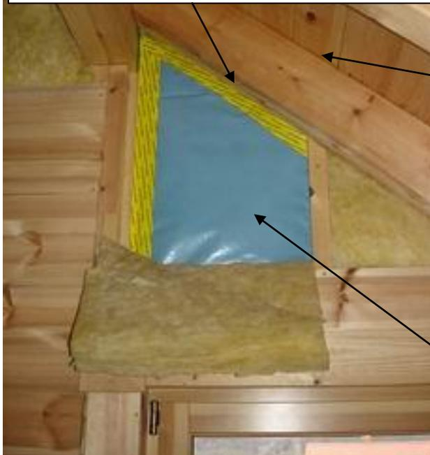
Eine weitere Ursache für die festgestellte Undichtigkeit könnte mit einer Stoßstelle der Dachdämmungsfolie zusammenhängen, die oberhalb der Kiefern Brettschalung liegt. In einem Video, das das Innere des Spaltes zeigt, ist dies ein weißer Bereich zwischen den reflektierenden Folienteilen der Dachdämmung (Mehrlagige reflektierende Dämmfolie TRISO 9 D der Firma ACTIS)
