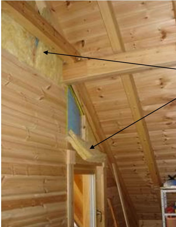
Am 28.02.09 haben sich durch Bewegungen der Dampfbremsfolie durch Winddruck Teile der 40 mm Dämmung aus Mineralwolle abgelöst. Diese Stellen waren bereits beim BlowerDoor Test auffällig (IR-Bild 3 und 4)
