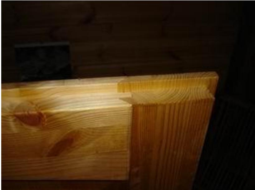
Ansicht von oben, Verbindung linke Seite (zur Türangel) abgelöst. Die Ablösung des oberen Elements ist erst im Juni 2010 aufgefallen.
